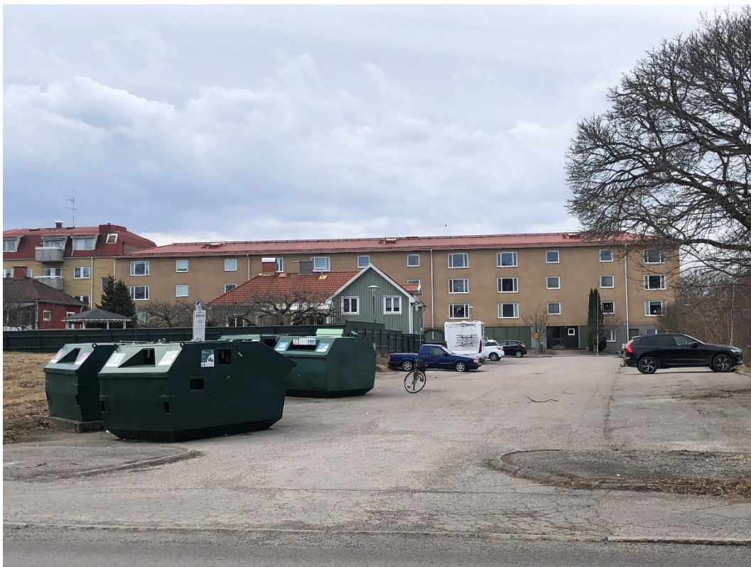
Befintlig parkering och återvinningsstation inom planområdet, sedd från Barnhemsgatan (nordöst) (Foto: WSP mars 2022).
